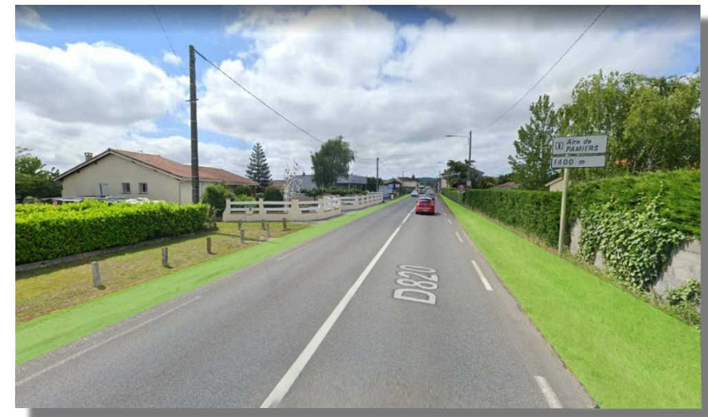
Figure 3 : Etroussure des accotements en entrée du hameau de Salvayre
